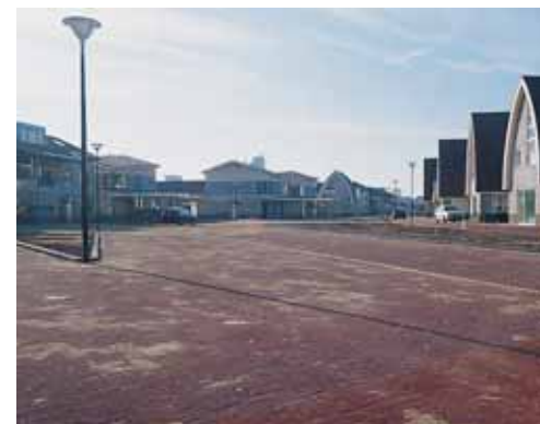
De bestrating van het 'Ontmoetingspad' in Fascinatio is nog volop in aanleg.
