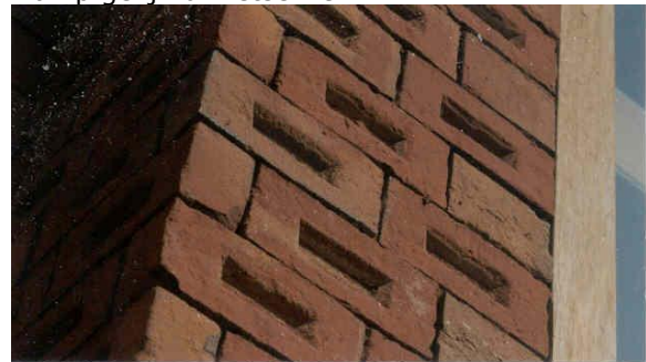
Klamp gelijmd metselwerk
