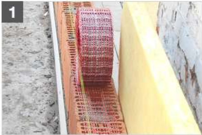
1. Plaats Murfor® Compact op de blokken
