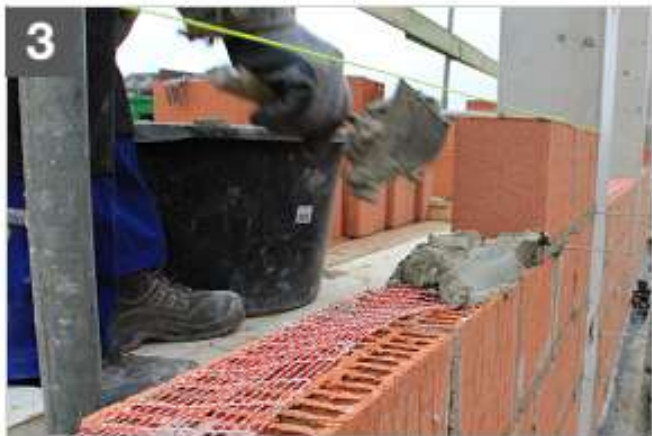
3. Breng een laag mortel aan
