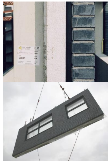
Dubbelschalig gevelelement met luchtspouw
